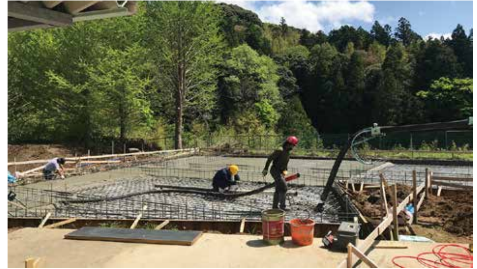
コンクリートミキサー車が入り、コンクリート打ち作業が始まりました。
