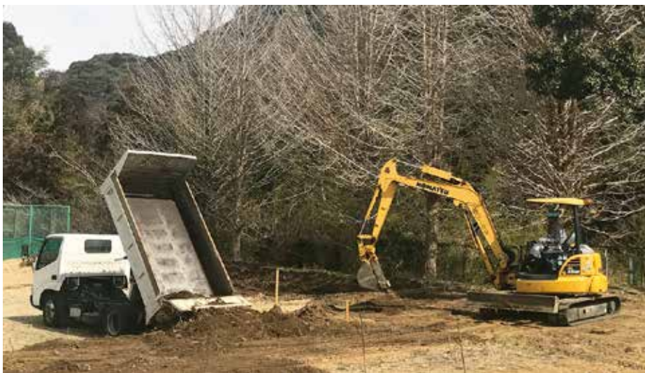
9日目（3月15日）グラウンド側に土を盛り造成工事が進んでいます。
