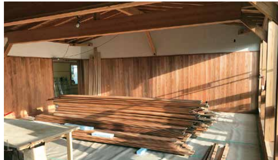
教室部分の壁材が張り終わりました。
