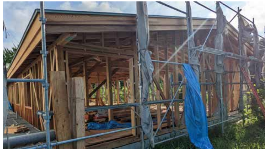
南側（廊下・教室）
