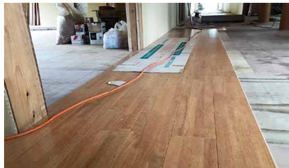
廊下 床張り工事
