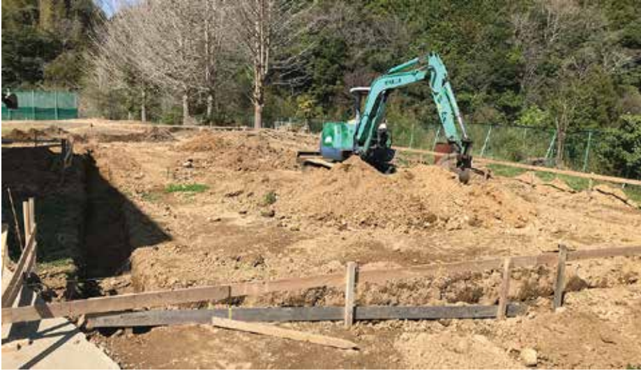
工事開始から1ヶ月、基礎工事が始まりました。
