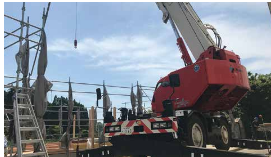
5月30日 大型クレーン車により柱が立てられていきます。
