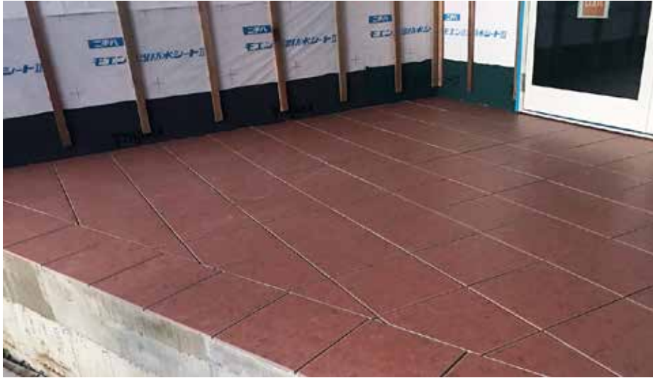
10月になり、春先の工事着工から200日以上が経過しました。
