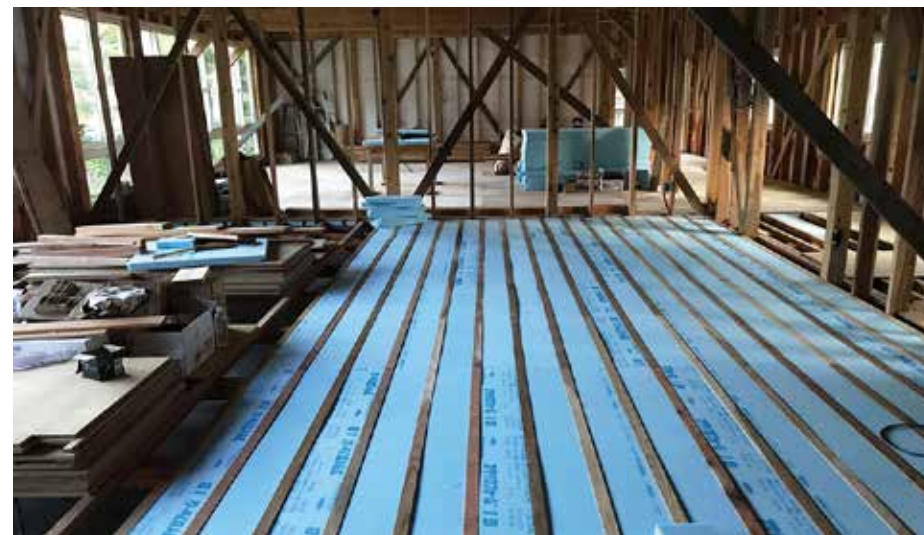
教室部分 床張り工事
