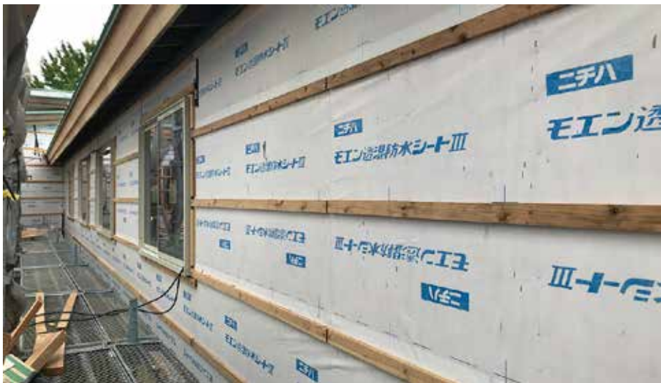
全面に防水シートを張り終わりました。
