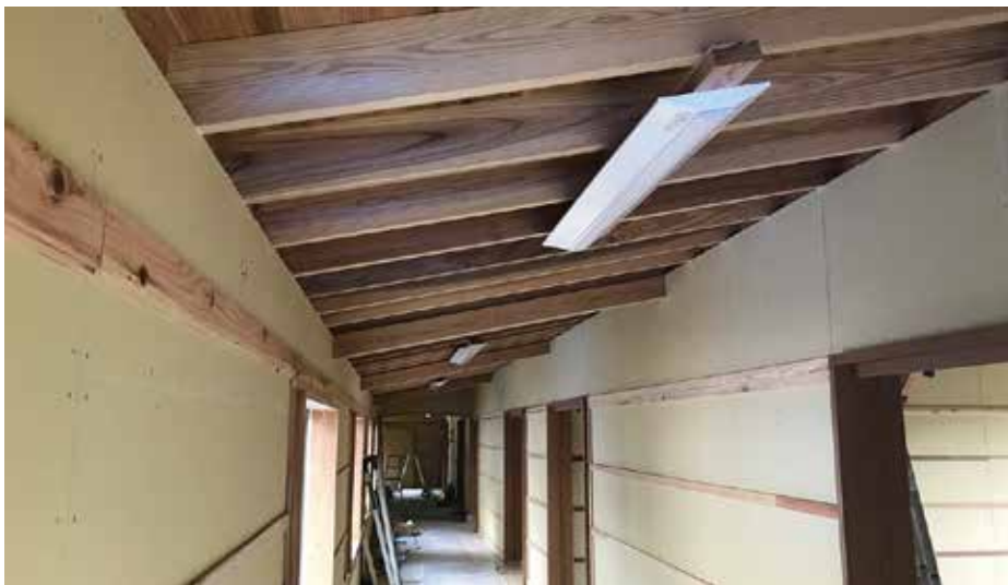
廊下の照明が取付けられました。
