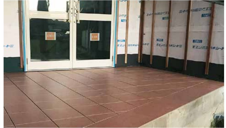
エントランスにタイルが貼られました。
