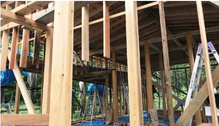
ホール部分。3本の丸太柱が見えます。
