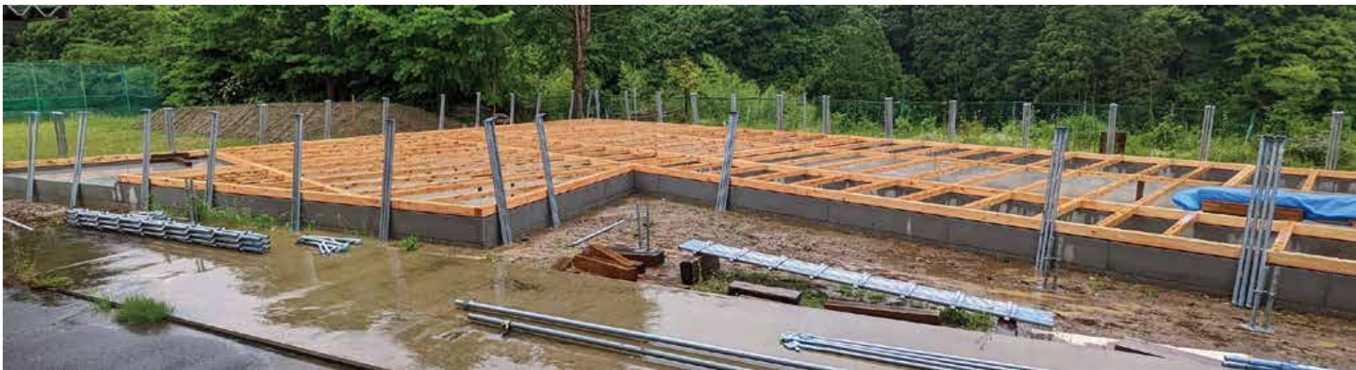
5月27日 土台敷きが終わり雨模様の中、足場組立が始まりました。
