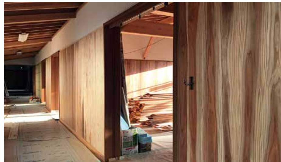
廊下の壁貼りが進んでいます。
