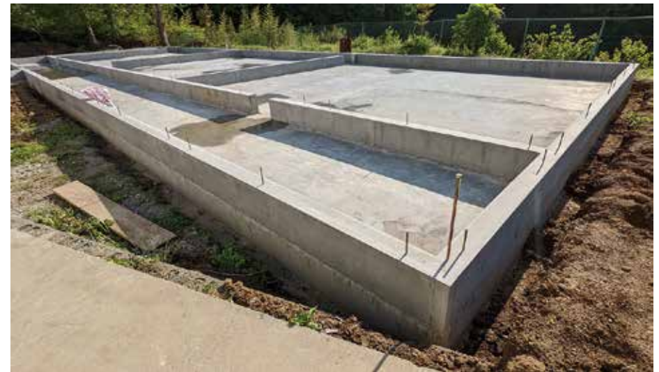
型枠が外れ、基礎工事仕上げとなります。
