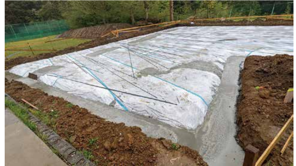
基礎工事が進んでいます。
