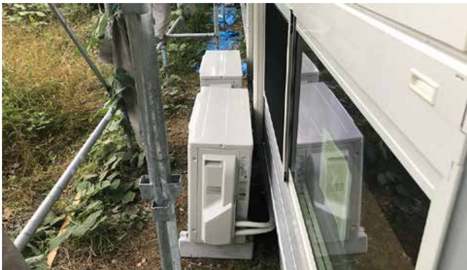
エアコン室外機が設置されました。
