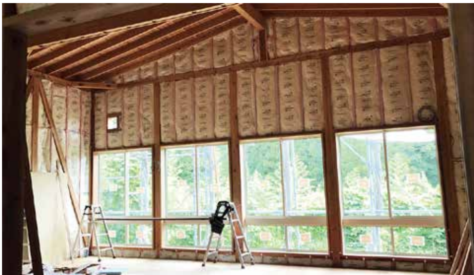
北側教室内部 (他2教室より高い天井)
