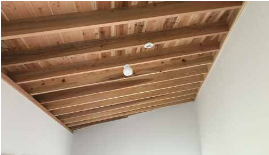
北側小部屋の天井です。
