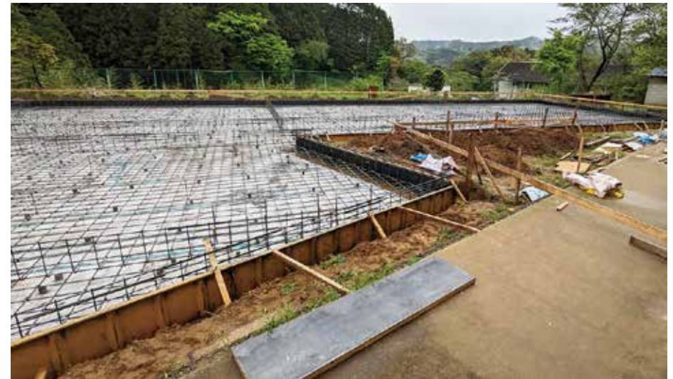
配筋作業が終わりました。
