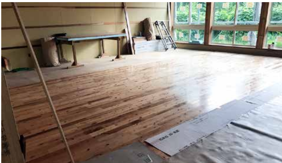
教室部分の床張りも、概ね終了しています。
