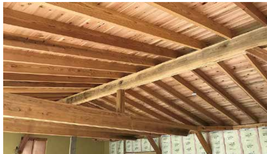
南側教室天井
