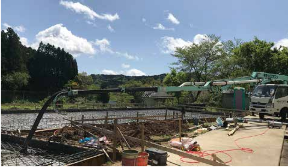
コンクリートミキサー車が入り、コンクリート打ち作業が始まりました。
