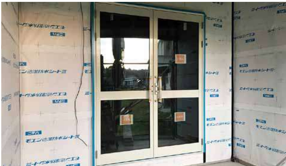
エントランスに扉が取付けられました
