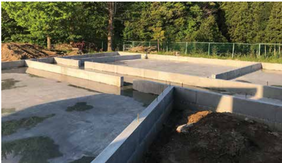
型枠が外れ、基礎工事仕上げとなります。
