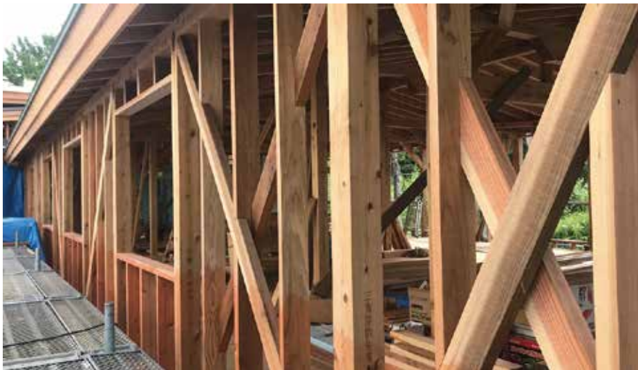
7月22日 窓サッシを取り付ける開口部下地枠造作中。
