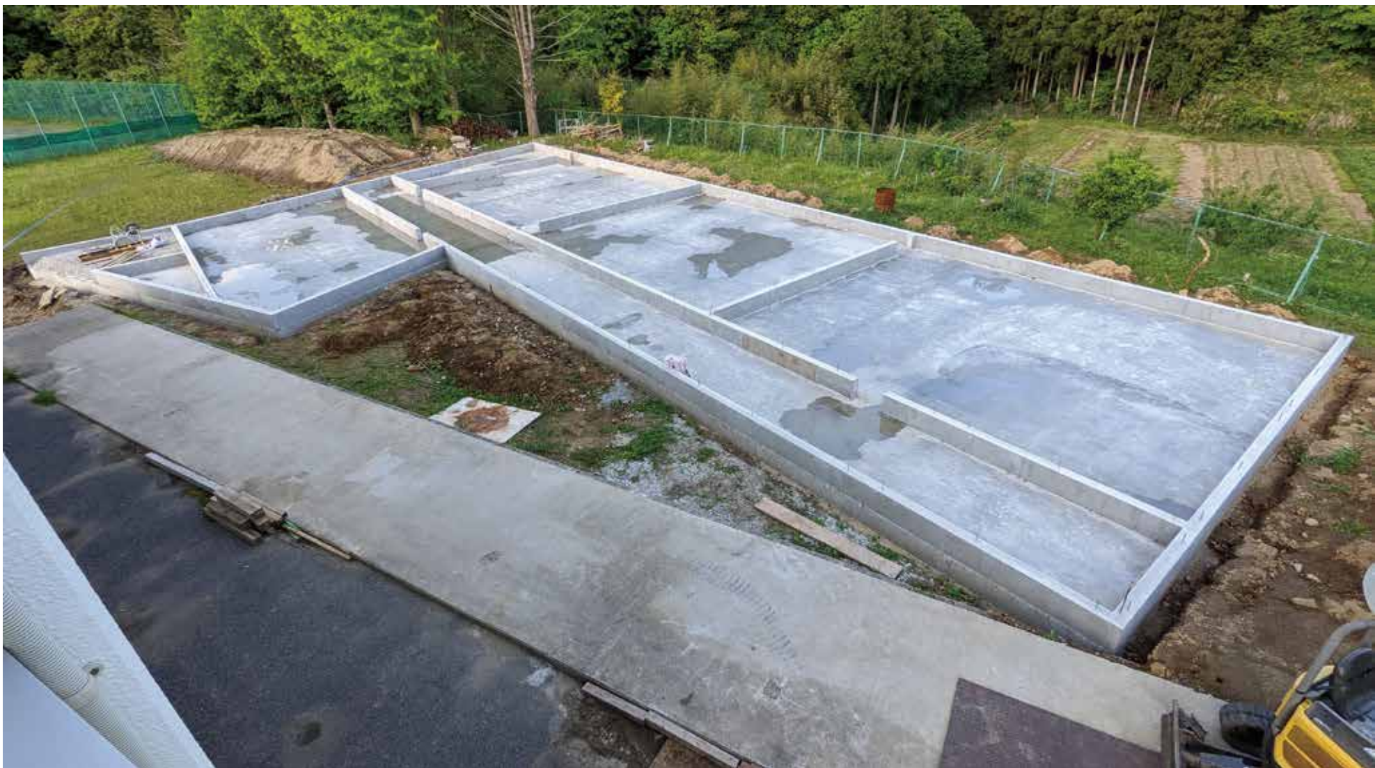
5月2日、基礎工事完成です。
