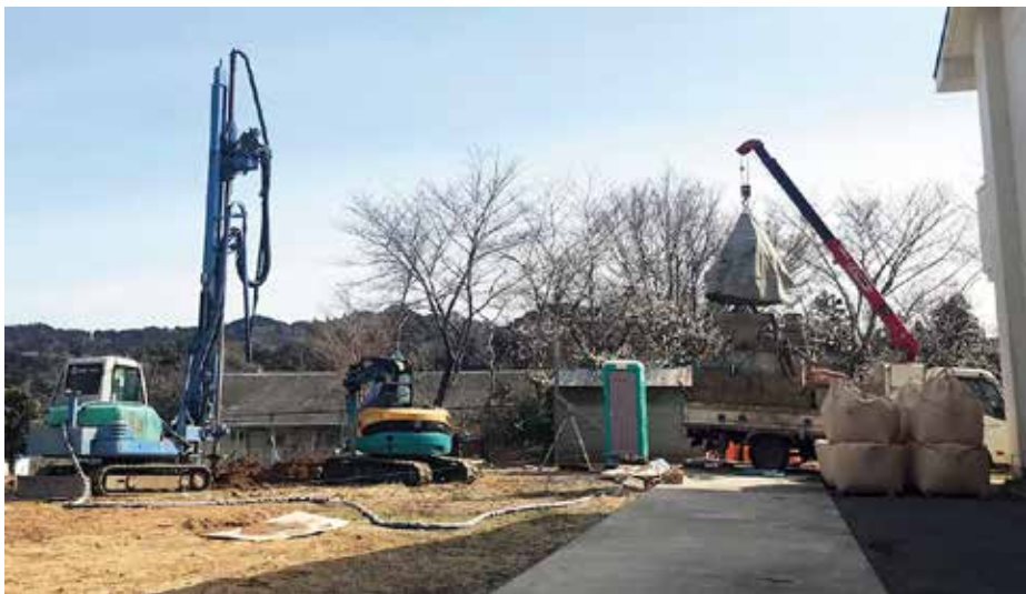
工事初日（3月7日）地盤改良（杭打ち）工事が始まりました。
