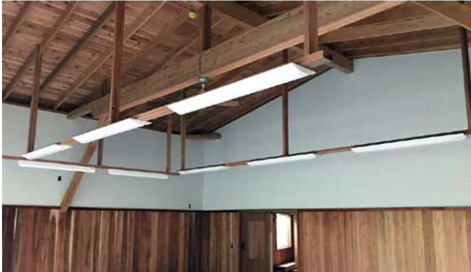
教室に照明が取り付けられました。
