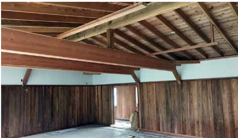
教室天井には、照明用の部材が付けられています。
