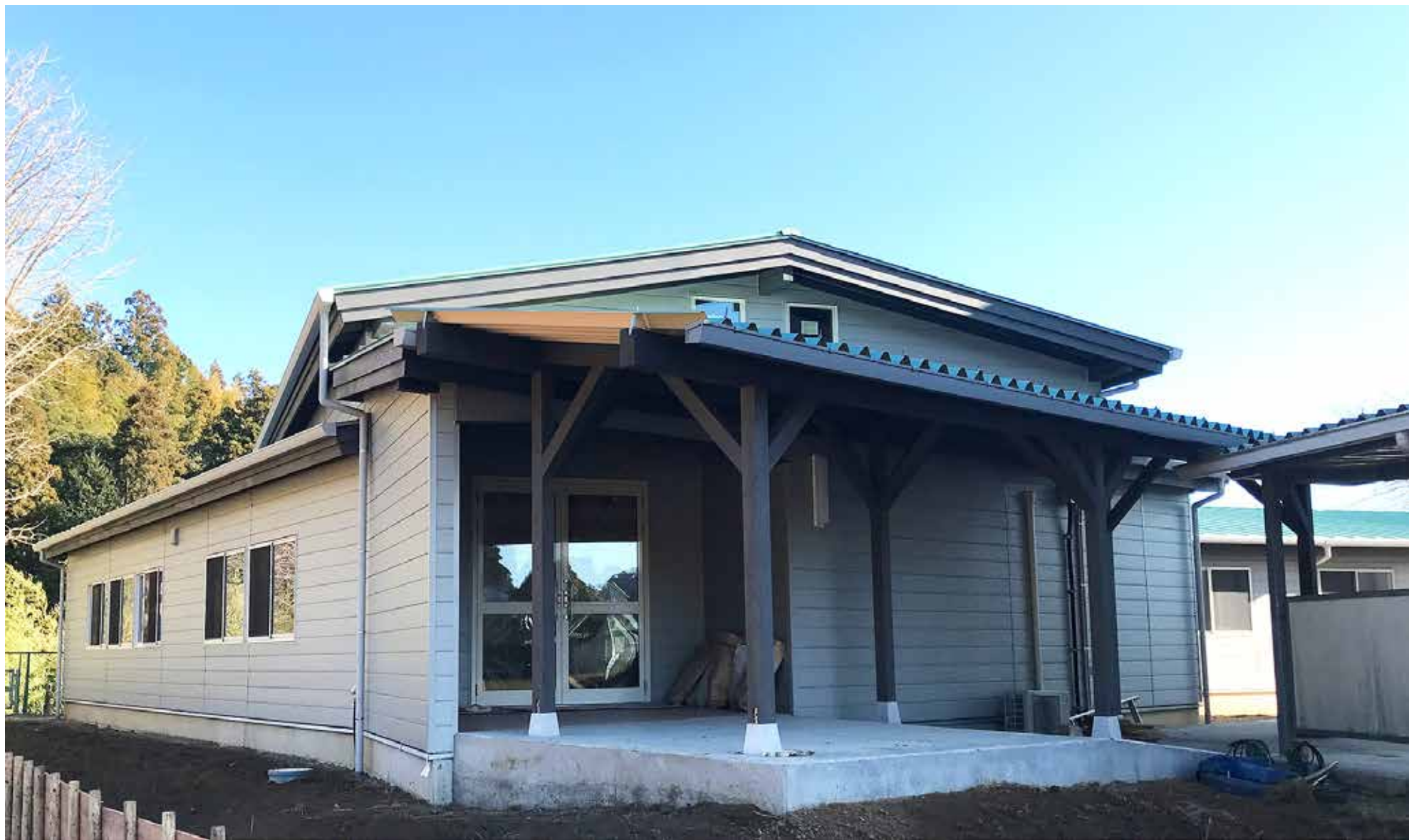
建築工事が完了し、施工業者より学校へ引き渡されました。
