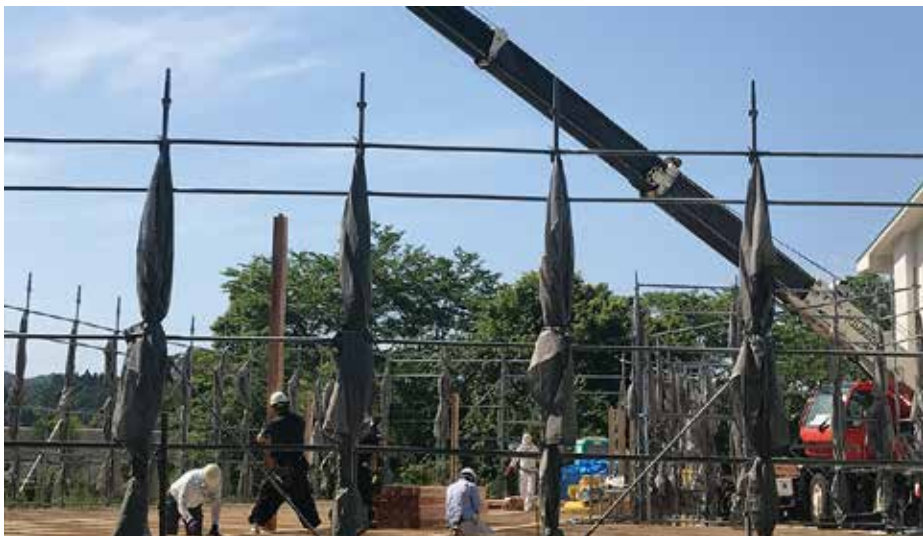
5月30日 大型クレーン車により柱が立てられていきます。
