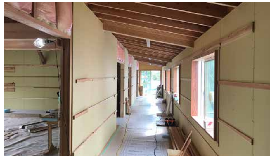
取り付け前のドア枠 ホールの床張りが終了し養生シートで覆われています。
