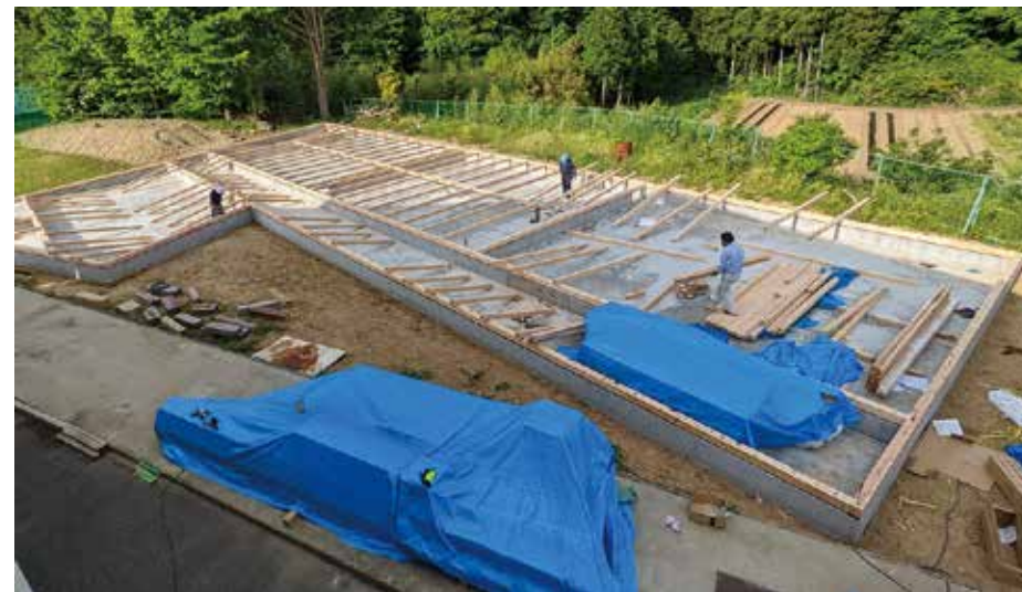
5月26日 土台敷き工事
