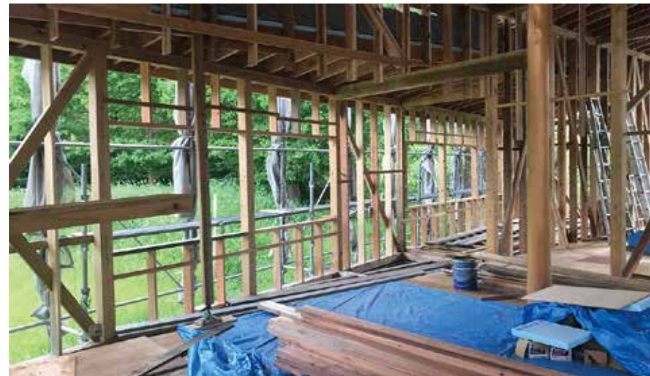
7月22日 窓サッシを取り付ける開口部下地枠造作中。
