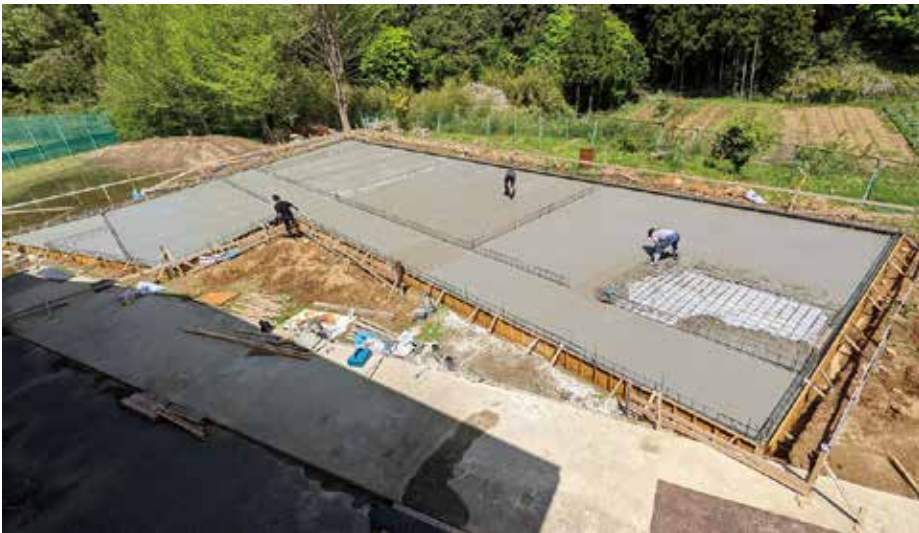
コンクリートミキサー車が入り、コンクリート打ち作業が始まりました。
