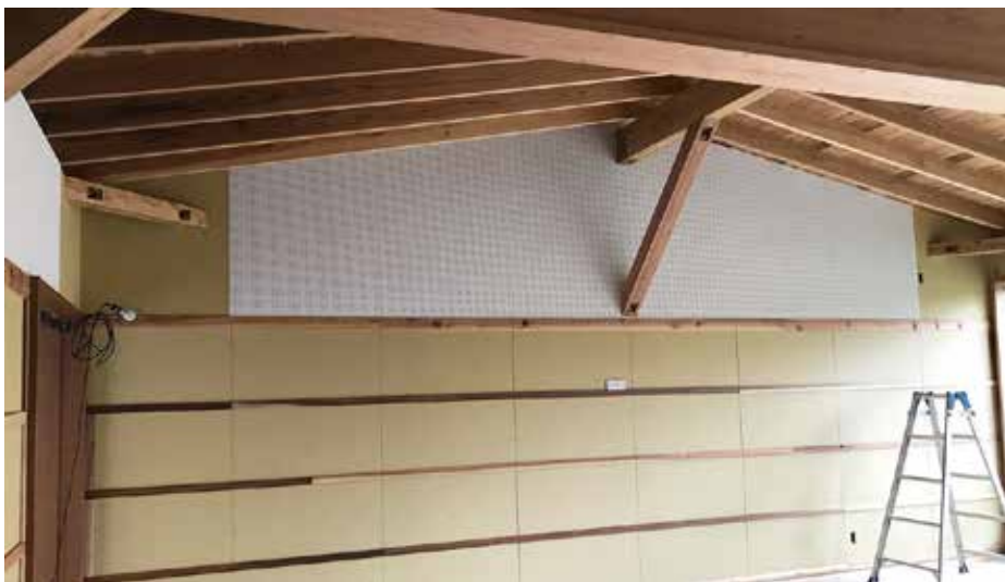
内装工事（有孔ボード張り・南側教室）。
