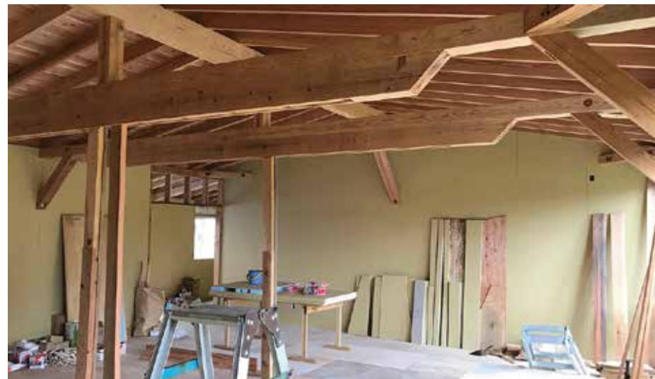
南側教室内部 各教室が壁で区切られました。
