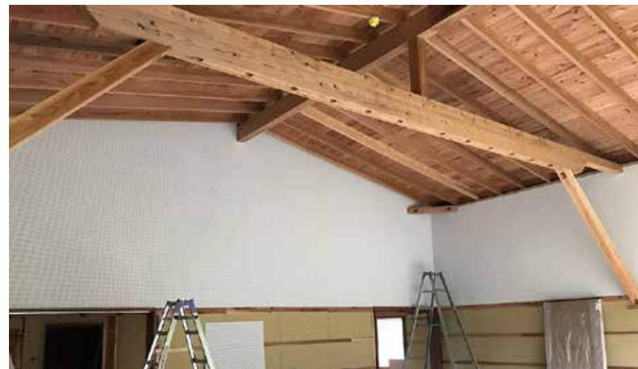
北側教室は有孔ボードが張り終わりました。
