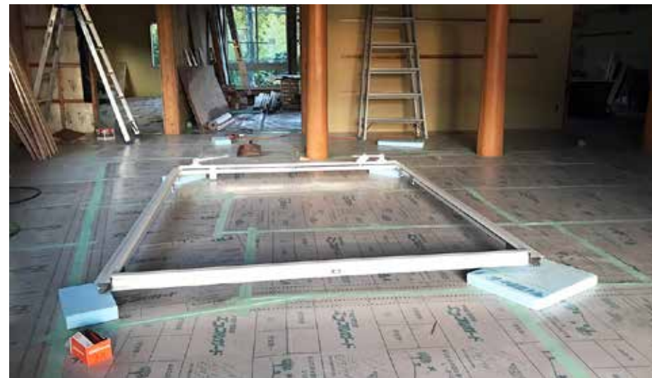
取り付け前のドア枠 ホールの床張りが終了し養生シートで覆われています。
