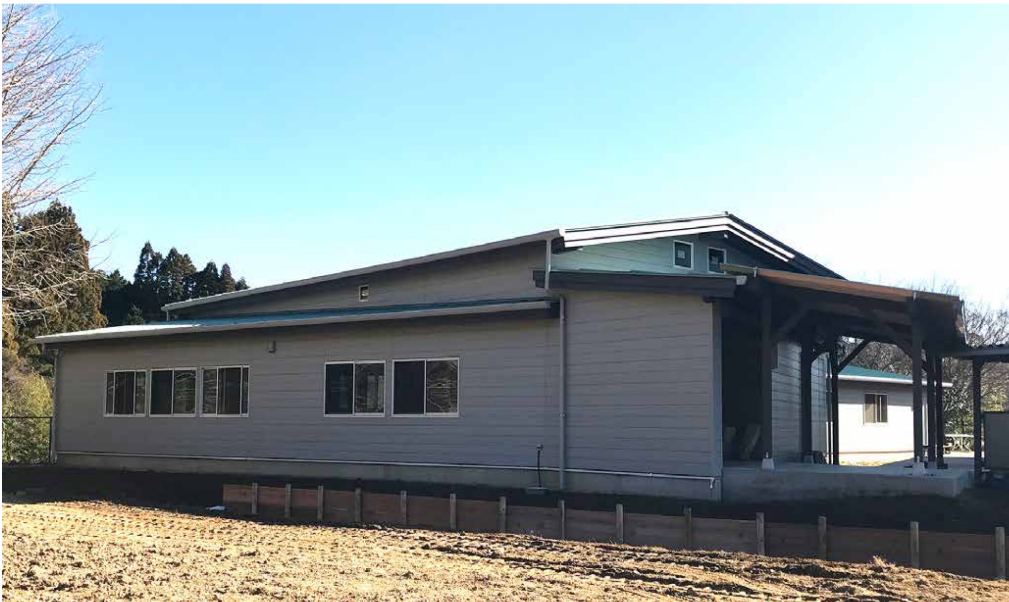
北側（グランド側）からの校舎全景。
