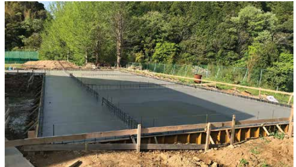
コンクリートミキサー車が入り、コンクリート打ち作業が始まりました。
